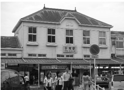
『折尾駅舎』 築93年、鉄道開通118年
