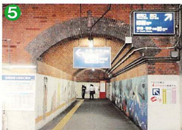
5 西口側・赤煉瓦連絡通路 取壊し予定 明治44年（1911）、アーチの濃い色の部分はデザイン。
