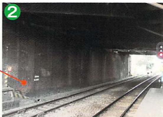
2 日本最古の立体交差 取壊し予定 蒸気機関車の蒸気があたっていた所はきれいな赤煉瓦色、上部はススで真っ黒。
