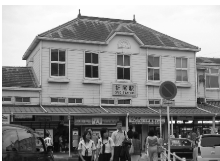
『折尾駅舎』築92年、鉄道開通117年
